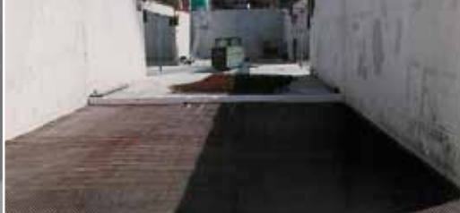
Замена бетонной подготовки под фундаментной плитой.
